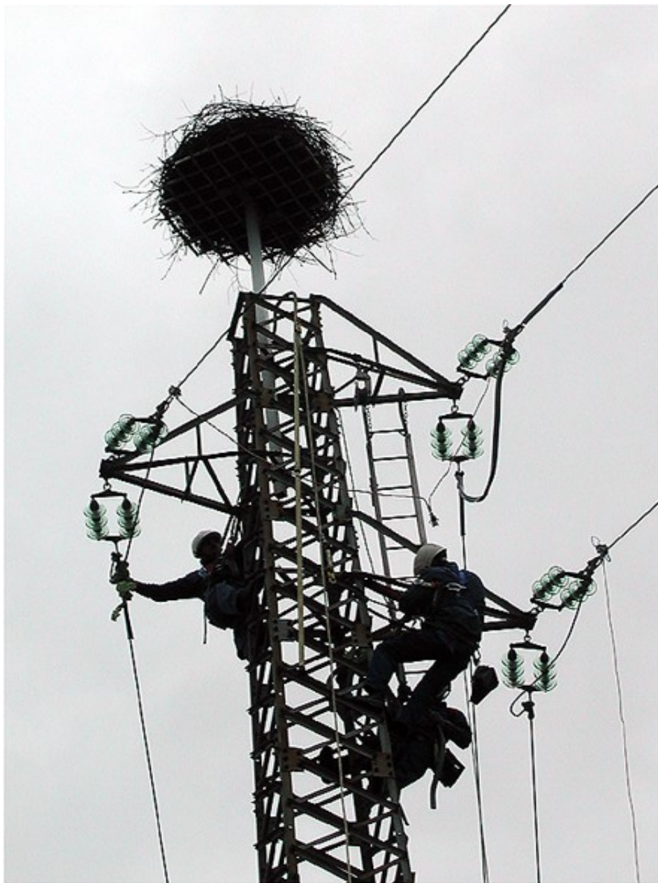
Intervento dell'Enel su un traliccio ai margini del Padule di Fucecchio
