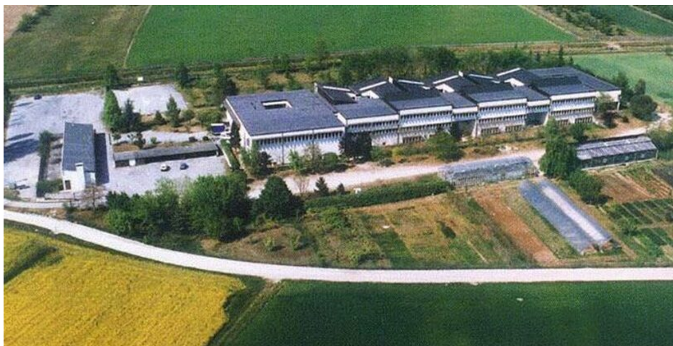
Veduta aerea dell'Istituto Tecnico Agrario “Bentegodi” a Buttapietra
