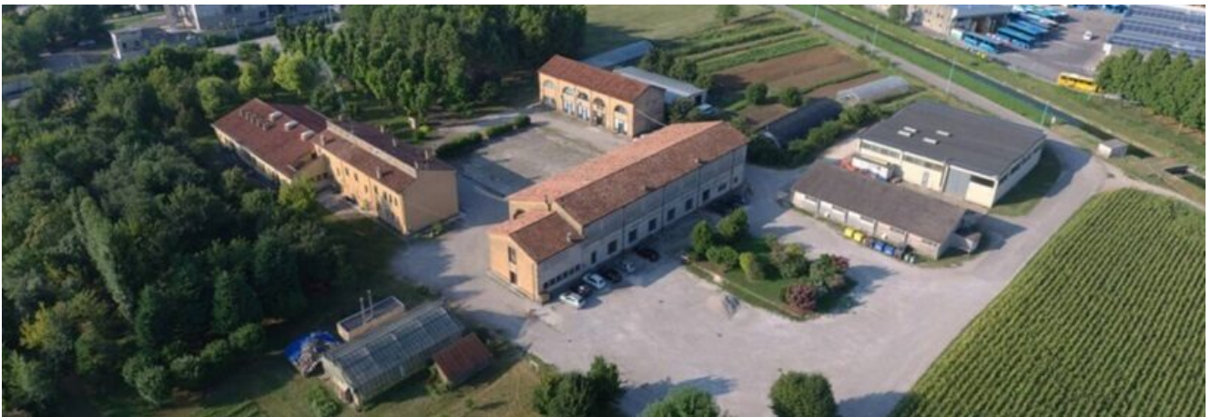
Istituto di Istruzione Superiore "Pietro Antonio Strozzi" - Sede di Mantova
