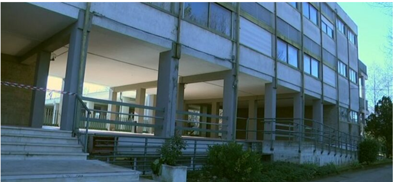
Sede dell'ITS Agroalimentare ad Avezzano
