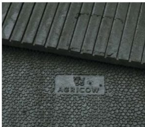
Figura 5 – Pavimentazione ricoperta in gomma.
